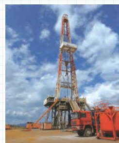
本プロジェクトの対象フィールドであるメネンガイ地域の地熱井掘削リグ
